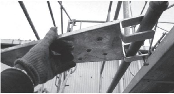
1.爪をステップガードの棧に差し込んで下さい。
