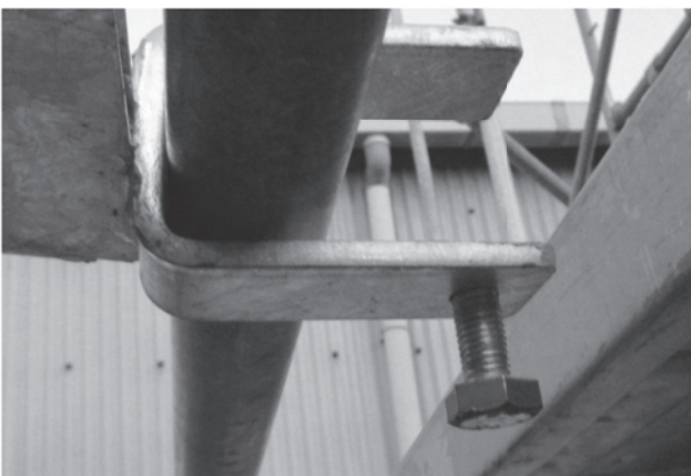
4.最後に抜け止めのボルトを締めて完了。勝手違いの時にはボルトが上に向きます。 この時には階段を2ステップ程上がって、上からボルトを締めて下さい。
