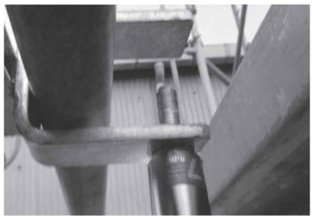
4.最後に抜け止めのボルトを締めて完了。勝手違いの時にはボルトが上に向きます。 この時には階段を2ステップ程上がって、上からボルトを締めて下さい。
