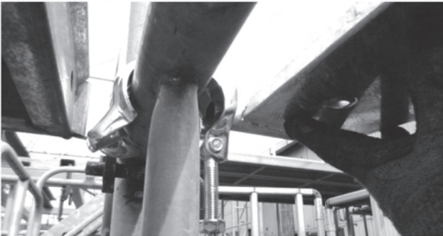
2.クランプを建枠の横架材に上からかぶせて下さい。 この時、クランプの位置は建枠の補剛材と踏板のつかみ金具の間として下さい。
