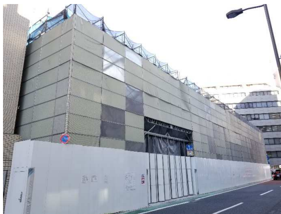
防音パネル/仮囲い(再リース品)
